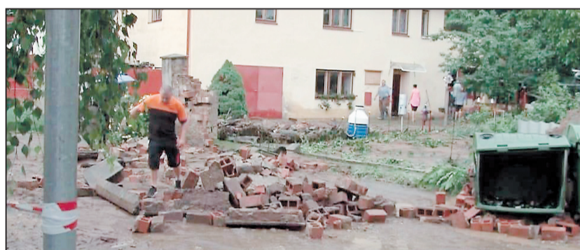
V BRTNICI povodeň pobořila zeď.
